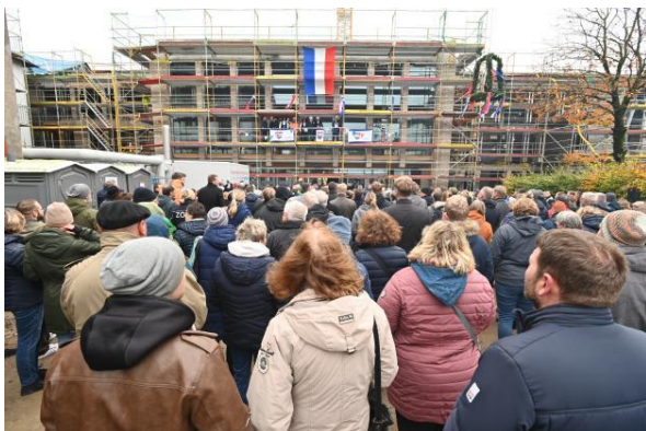
Richtfest für das neue Kreishaus in Itzehoe im November 2023: Der Neubau wird die Verwaltung als Arbeitgeber attraktiver machen, sagt Steinburgs Landrat. Foto: Andreas Olbertz
