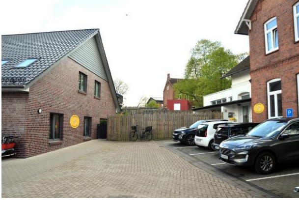
Die Kita Kastanienallee besteht aus dem Altbau mit Verwaltung (rechts) und dem Neubau. Foto: Christian Lipovsek
