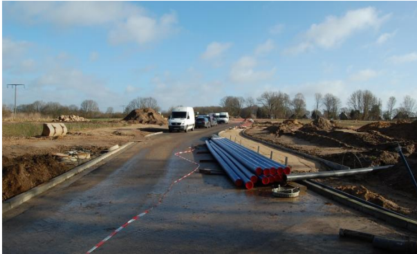
Das neue Baugebiet an der Luisenberger Straße in Kellinghusen erhält Wasseranschluss und Gehweg. Foto: Gisela Tietje-Räther
