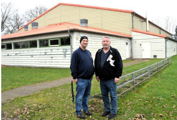
Kay Konopka (links) und Jens Elsner sind positiv gestimmt, dass zumindest die Heizungs- und Lüftungsanlage in der Sporthalle (im Hintergrund) repariert werden sollen. Foto: Christian Lipovsek
